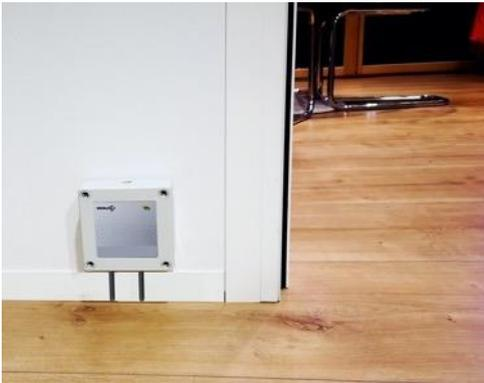
Dans cette version, le capteur peut détecter une fuite d'eau localement en un seul endroit, comme sur la photo ci-dessous. Il faut positionner dans ce cas le boîtier de façon que les électrodes soient juste légèrement au-dessus du sol.
